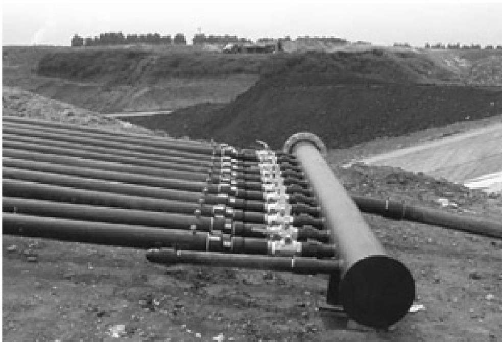
Рисунок 4. Закладка горизонтального коллектора полигонного газа
