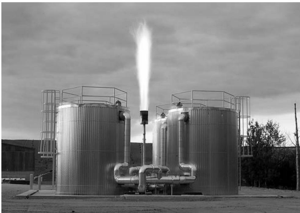
Рисунок 5. Пример факела для сжигания полигонного газа
